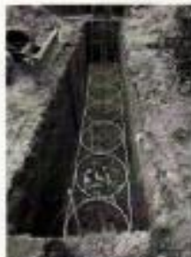
水平スlinky地中熱交換器(横置)
