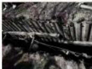
水平スlinky地中熱交換器(縦置)
